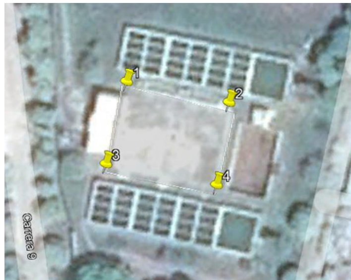
Figura 3 Vista aérea planta de tratamiento de agua potable
