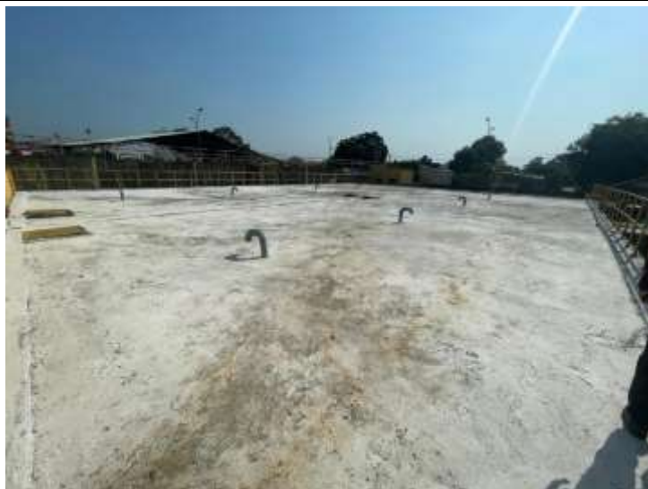
Figura 2 Área de instalación módulos solares
