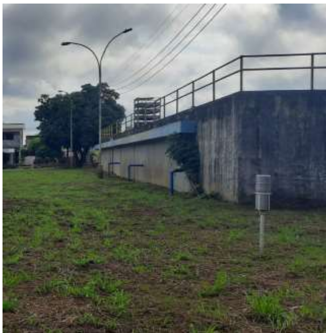
Figura 3 Vista lateral del lugar de instalación de módulos solares
