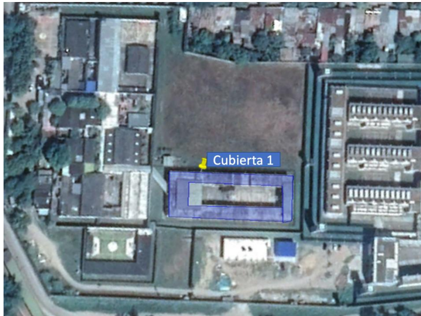
Figura 4. Vista aerea de la cubierta 1
