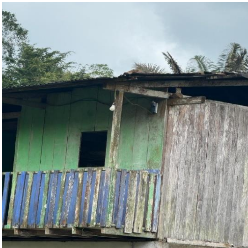
Fig. 1. Usuario conectado ilegalmente a la red de distribución de la JAC Bellavista Fuente: Visita de campo de la CGR
